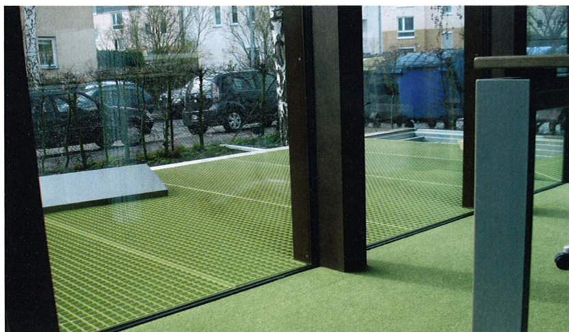
Der limonengrüne Farbton des Bodenbelags wird von den Gitterrostbalkonen vor den Fenstern aufgenommen und stellt so eine Verbindung her. Bild: Deon AG
